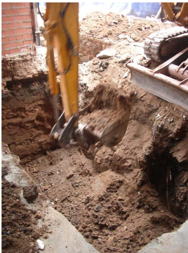
Fotografia 4 Parades 691-693, 697-699, 700-702. Procés d'excavació.
